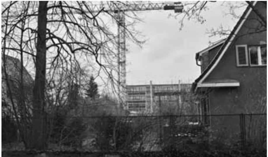
Die Betonstützen der 12 Meter hohen Turnhalle recken sich bereits, gleich hinter den Eigenheimgärten, in die Höhe.
